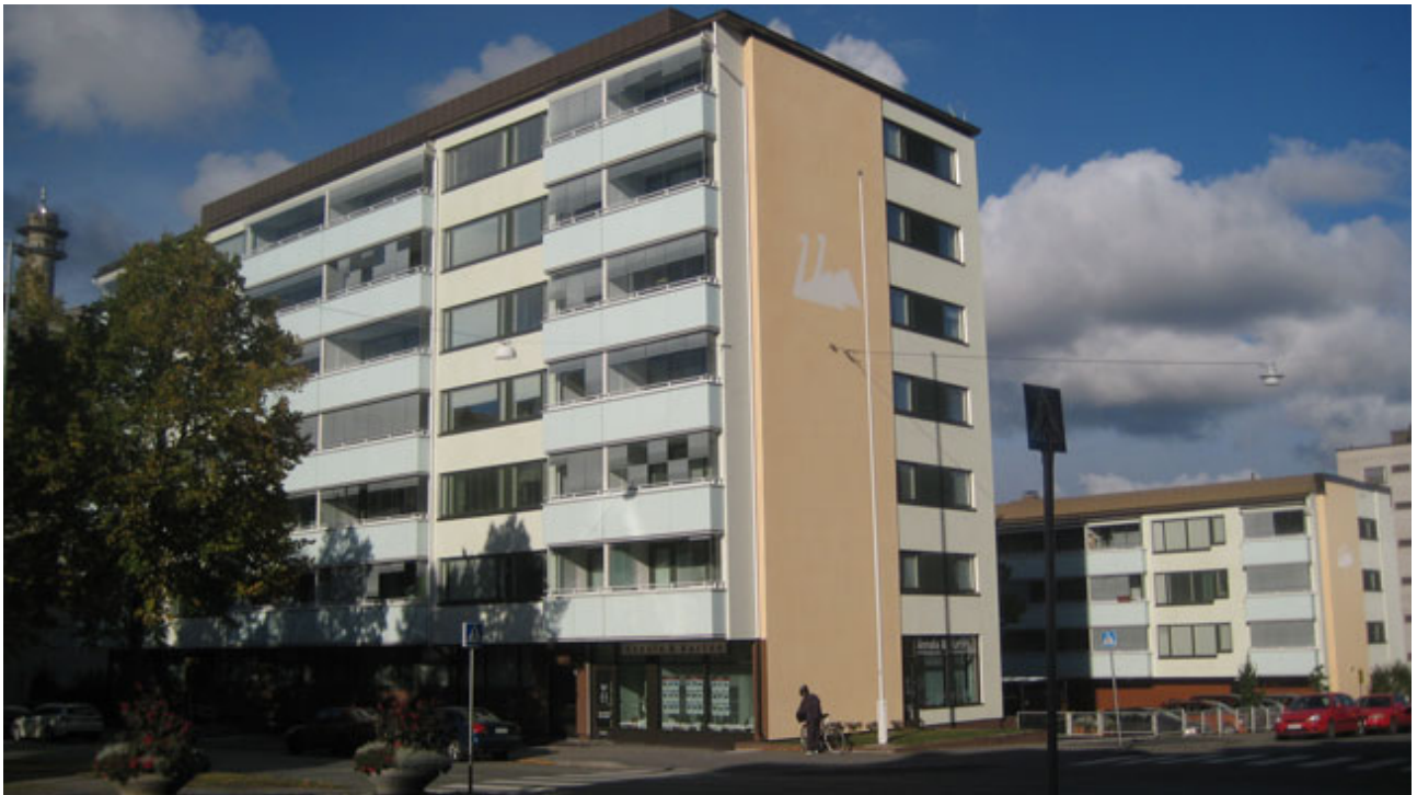
Asunto Oy Kirkkopuistikko 9 julkisivuremontin jälkeen.
