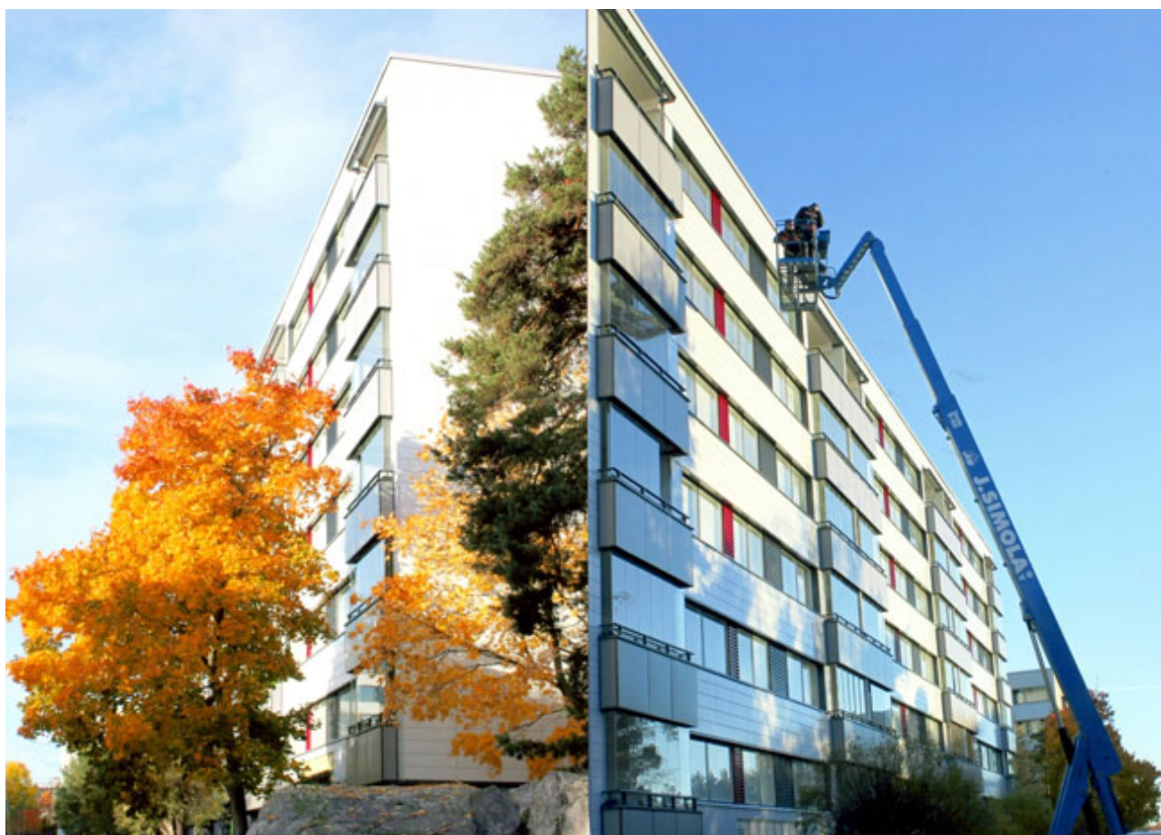
Asunto Oy Raskinpolku 8 kuvaparissa ennen ja jälkeen julkisivuremontin.
