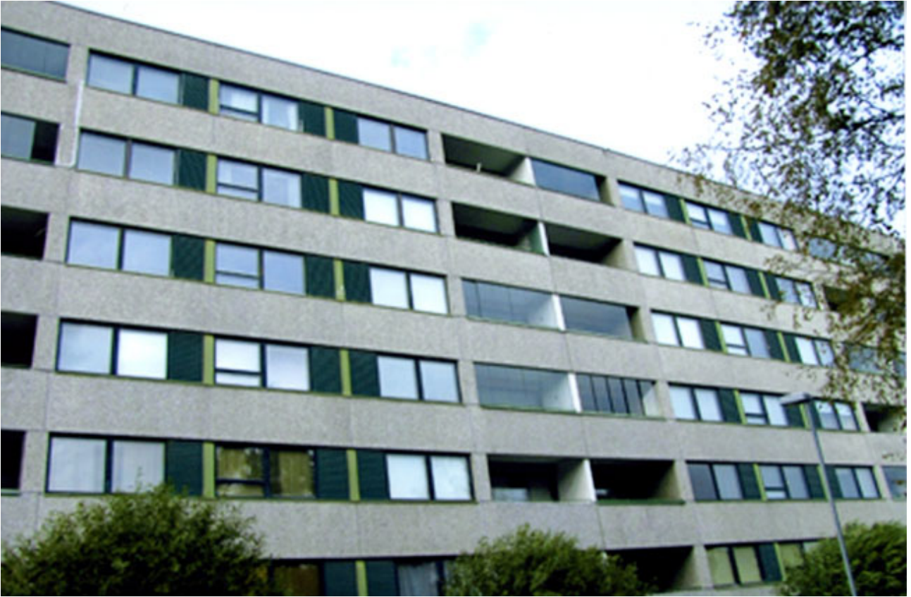
Asunto Oy Raskinpolku 8 ennen julkisivuremonttia.
