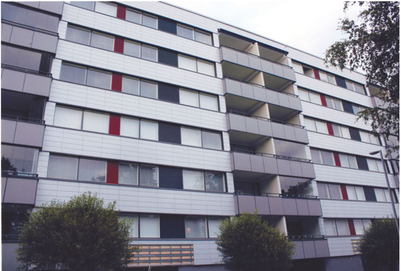
Asunto Oy Raskinpolku8 julkisivuremontin jälkeen.
