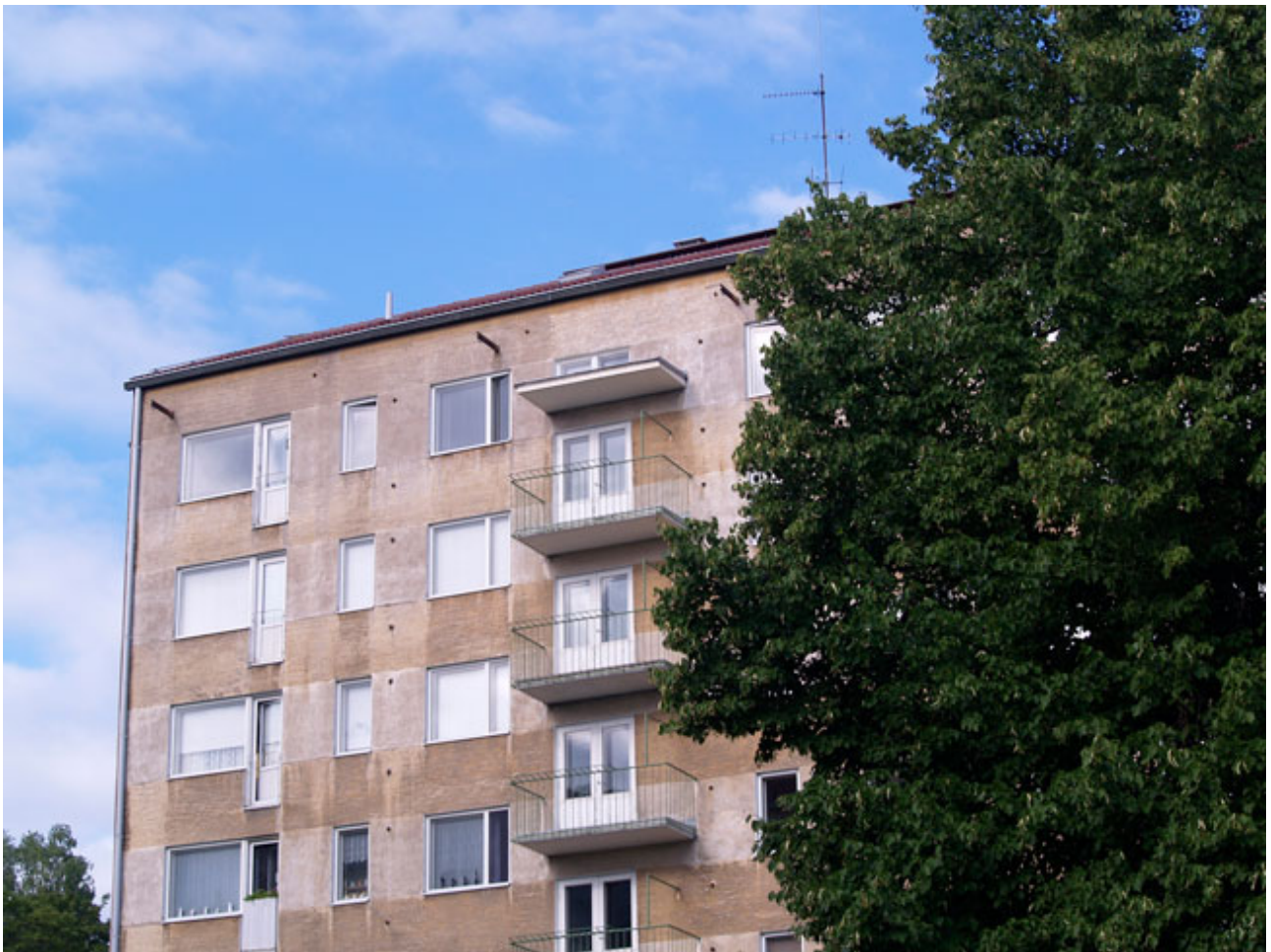
As Oy Honkamäenniitty ennen julkisivuremonttia.
