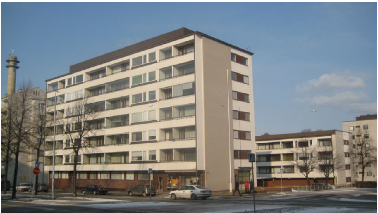
Asunto Oy Kirkkopuistikko 9 ennen julkisivuremonttia.
