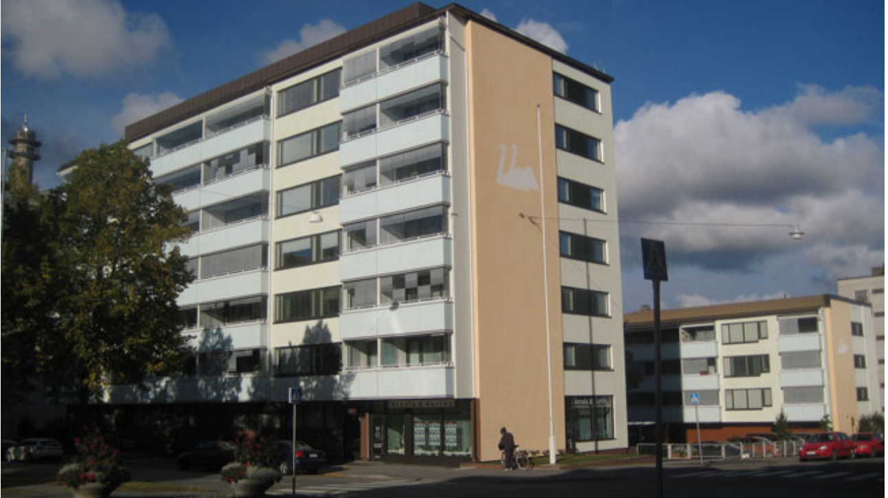
Kuvassa kunniamaininnan saanut Bostad Ab Kyrkoeshplanaden Asunto Oy Kirkkopuistikko 9 julkisivuremontin jälkeen.
