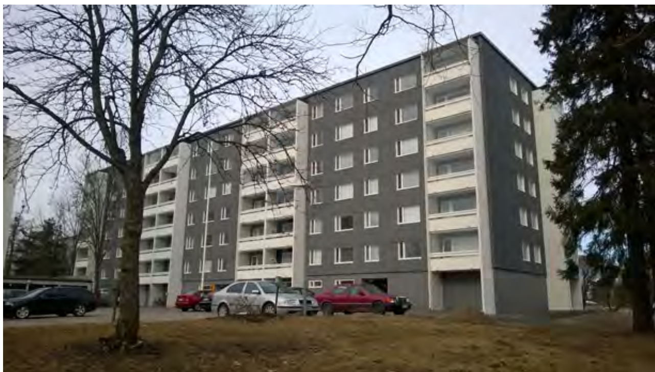
Asunto Oy Forssan Rytyntyöli julkisivuremontin jälkeen.
