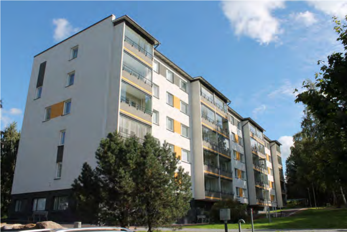
As Oy Korkearinne isomman talon sisäpihan puoleinen julkisivu remontin jälkeen.
