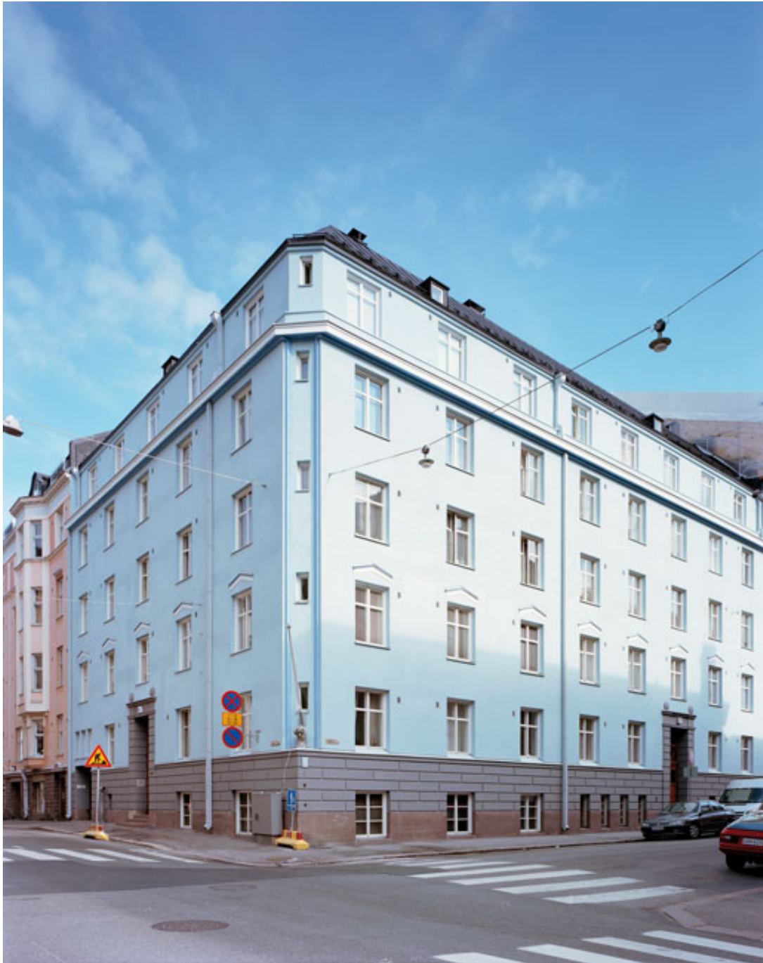
Kunniamaininnan saanut As Oy Eerikinkatu 31 julkisivuremontin jälkeen.
