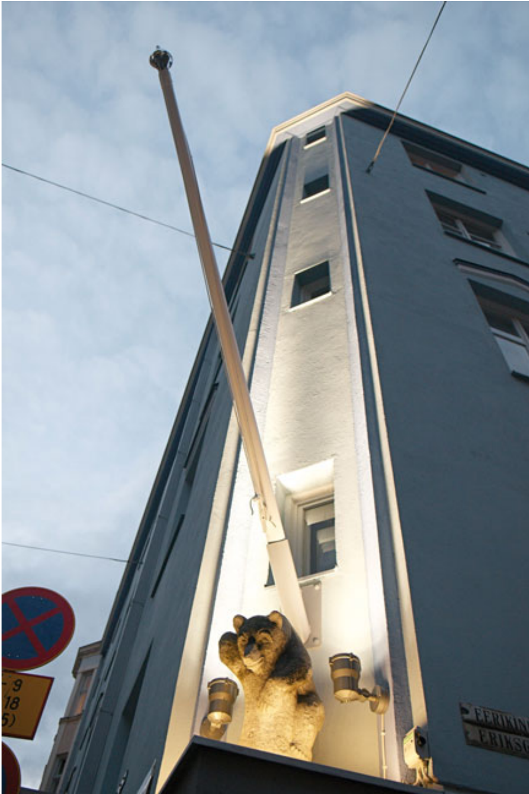
As Oy Eerikinkatu 31:ssä palautettiin myös julkisivukoristeet.
