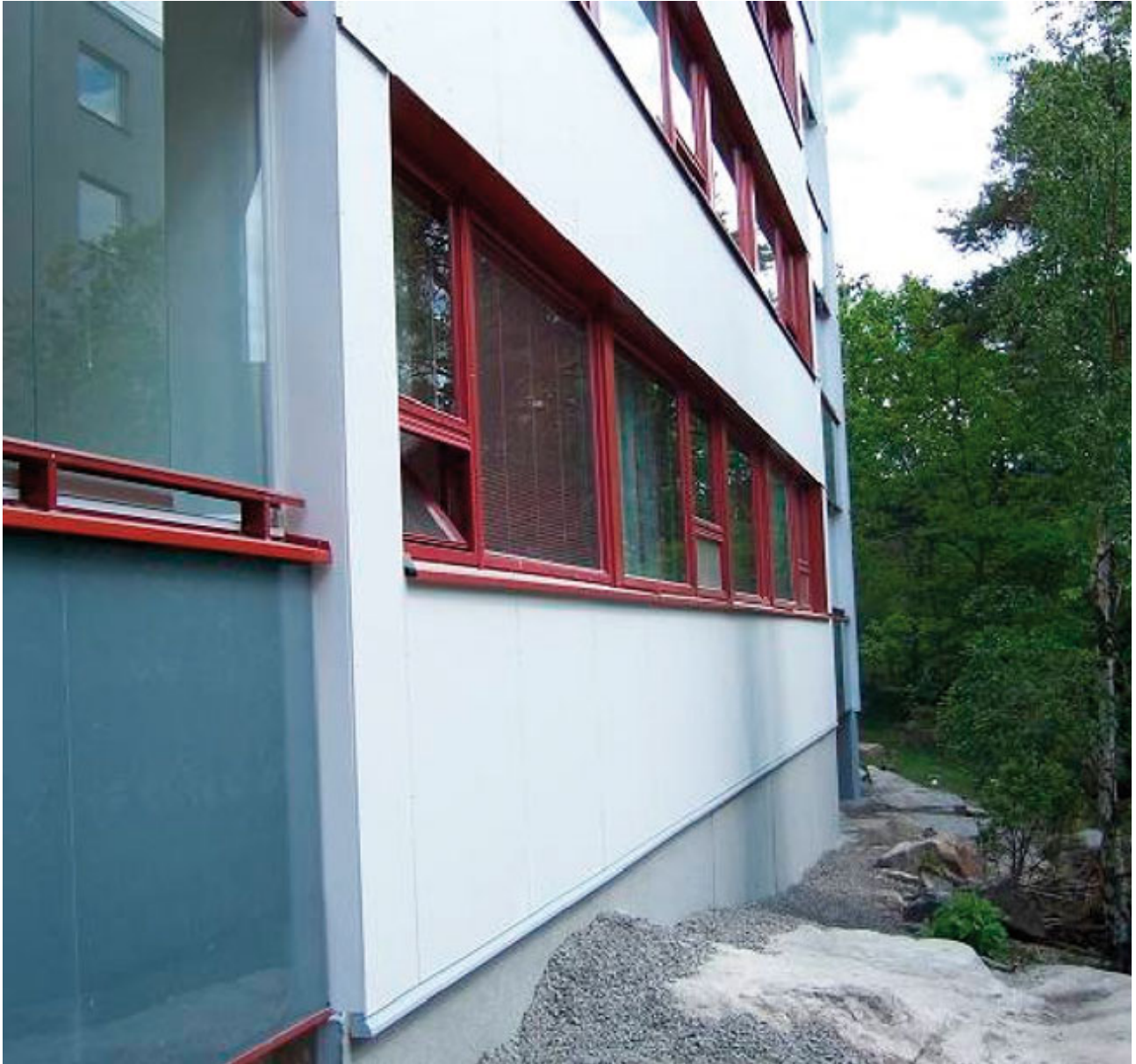
As Oy Raskintornia julkisivuremontin jälkeen.
