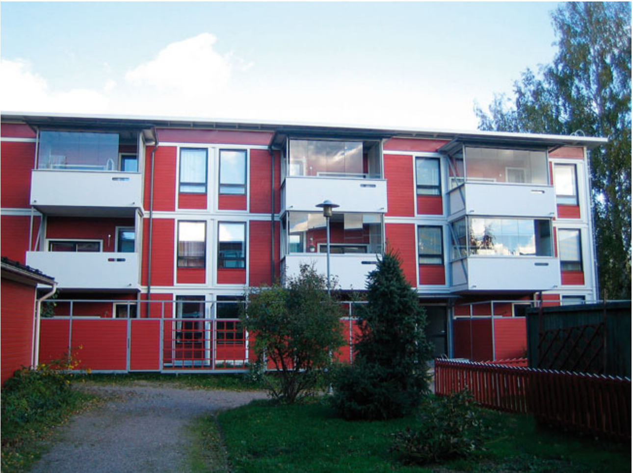
Kunniamaininnan saanut As Oy Urkupillintie 7 julkisivuremontin jälkeen.
