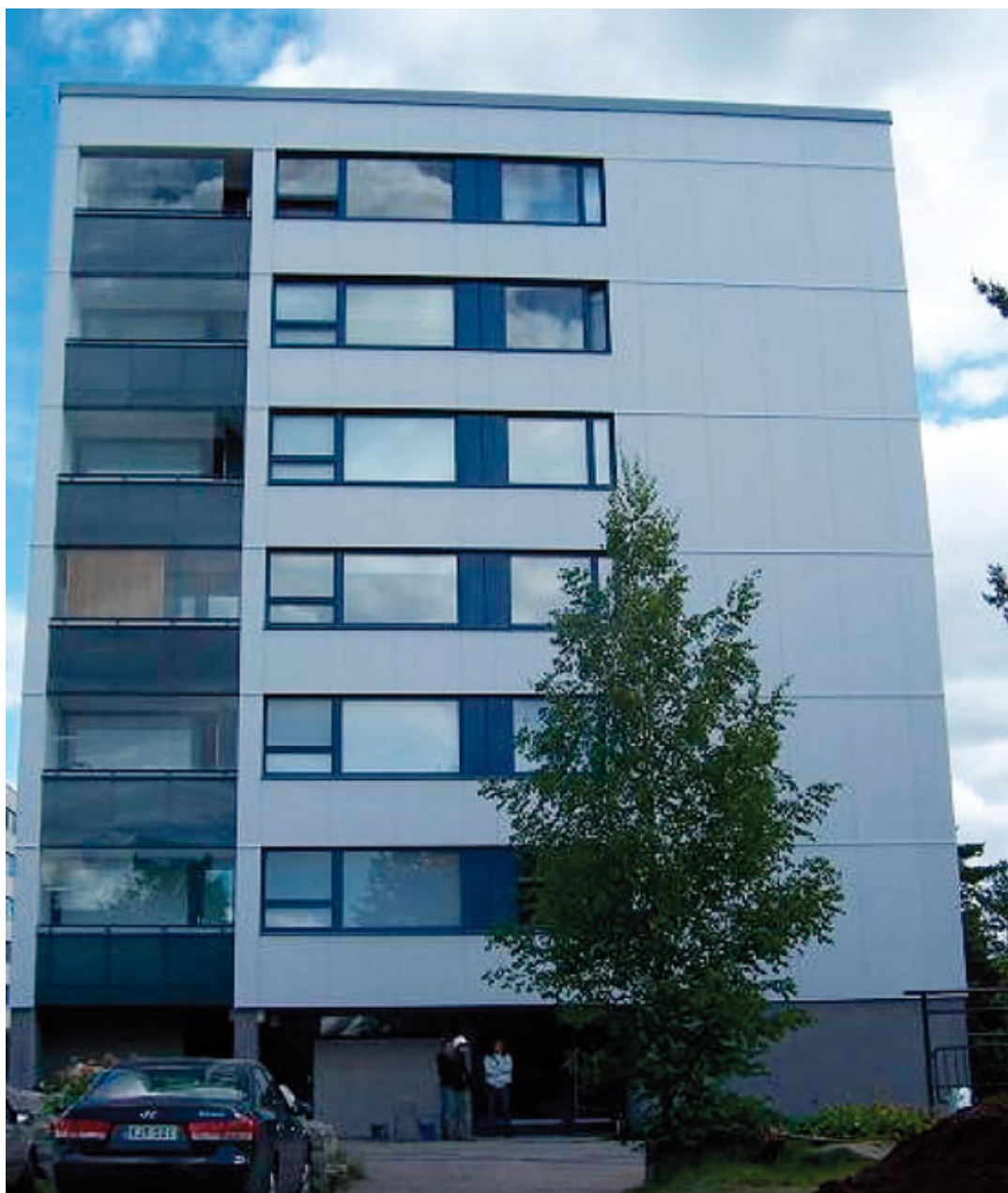
As Oy Raskintornien julkisivua remontin jälkeen.
