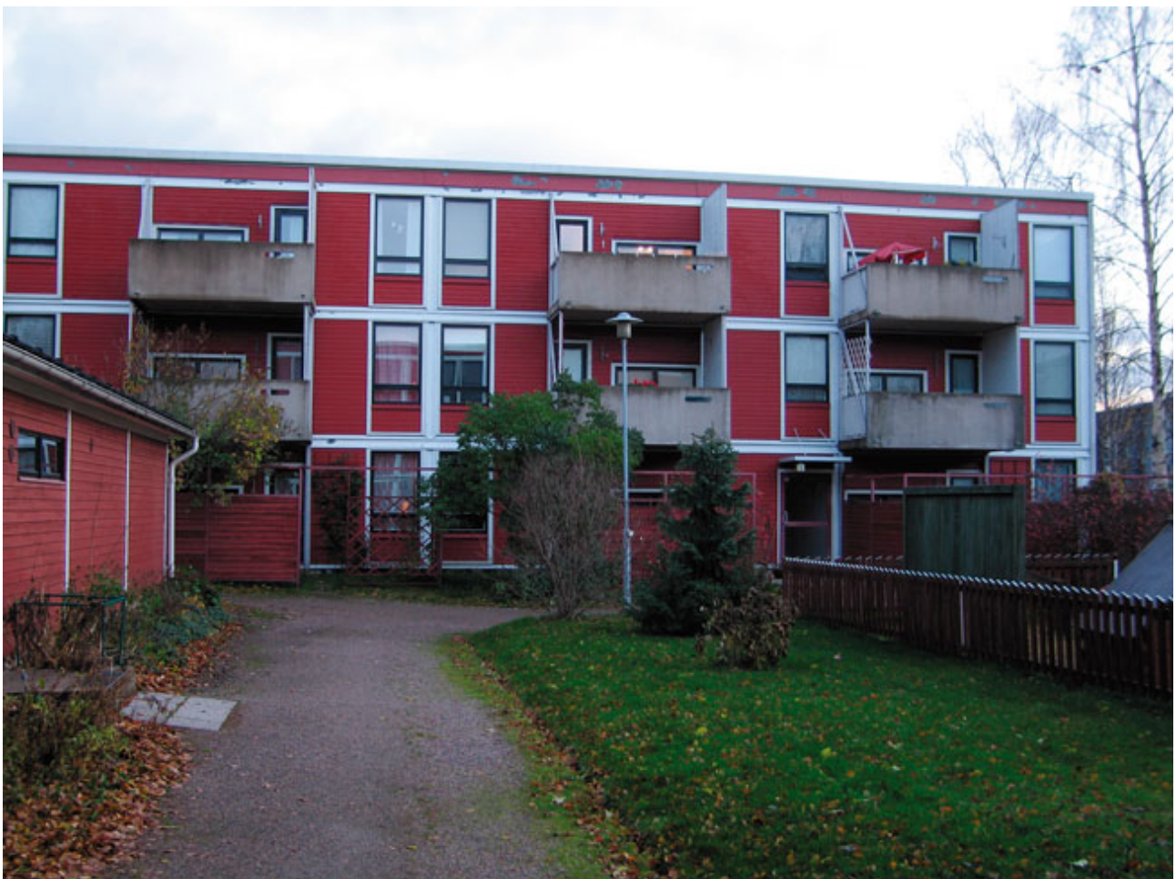
Tältä Urkupillintie 7:ssä näytti ennen julkisivuremonttia.
