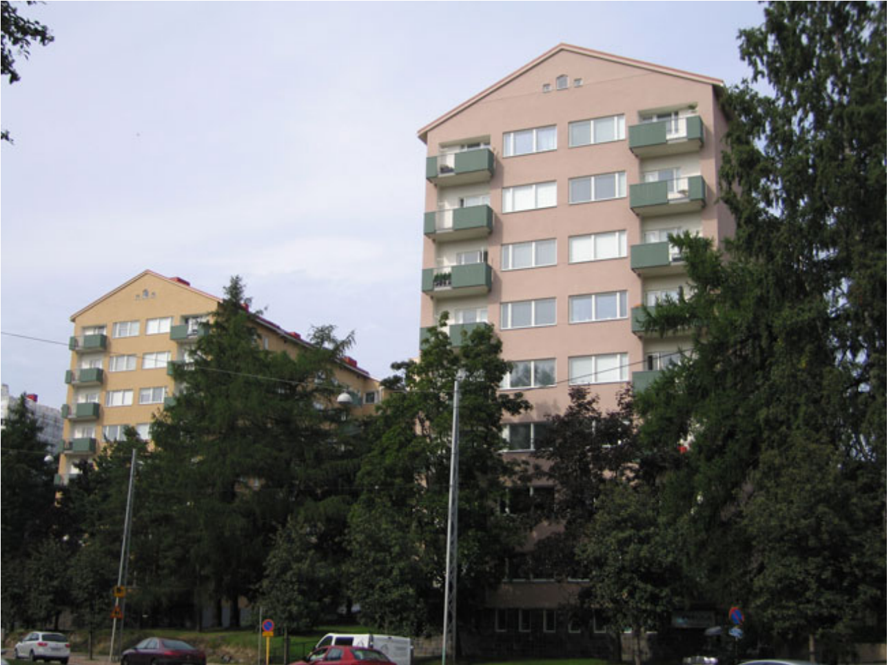
Asunto Oy Mannerheimintie 83-85 julkisivuremontin jälkeen.
