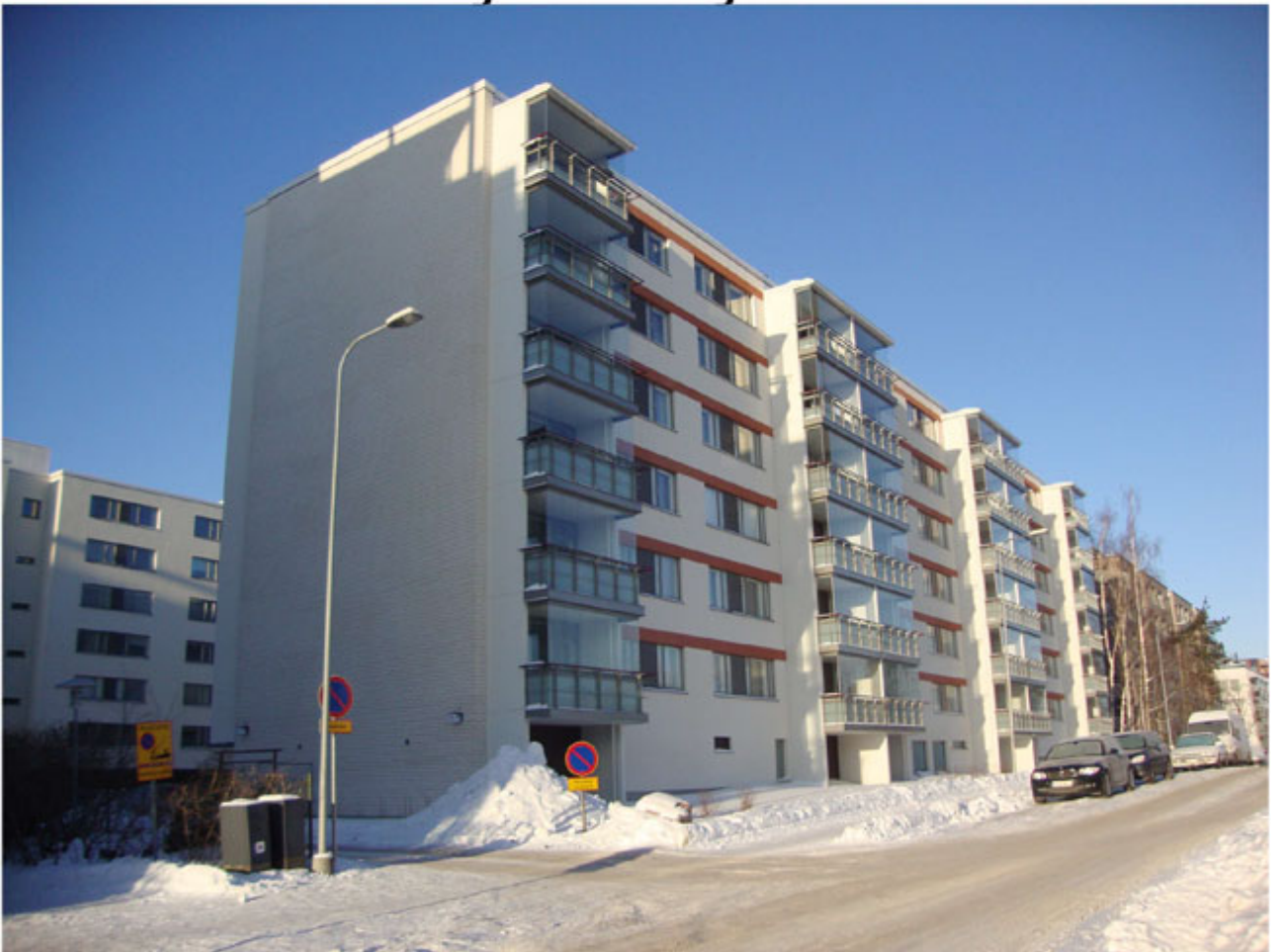
Asunto Oy Vattuniemenkatu 4 julkisivuremontin jälkeen.
