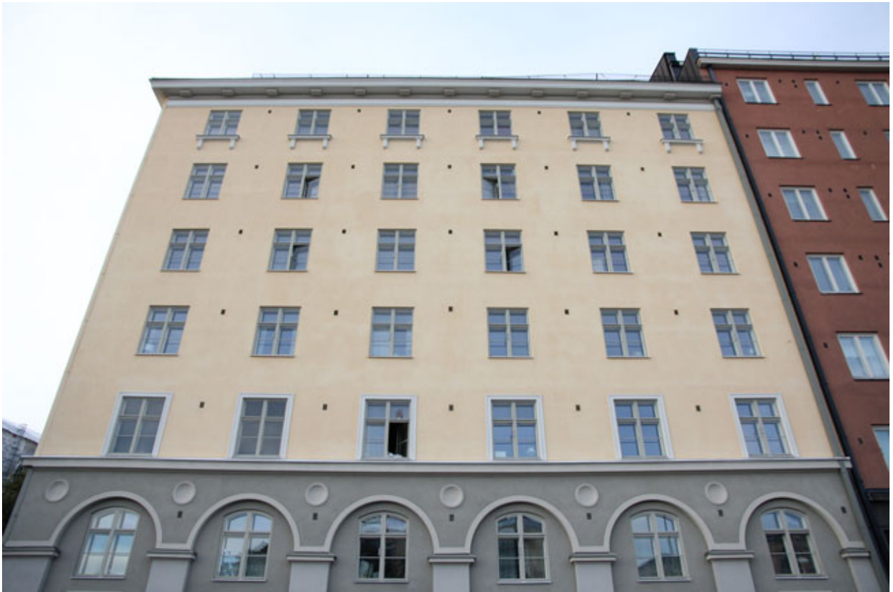
Kunniamaininnan saanut Asunto-osakeyhtiö Pääskylänkatu 7 julkisivuremontin jälkeen.
