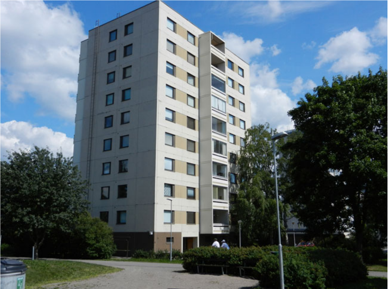
Asunto Oy Näsinamurin julkisivua ennen julkisivuremonttia.
