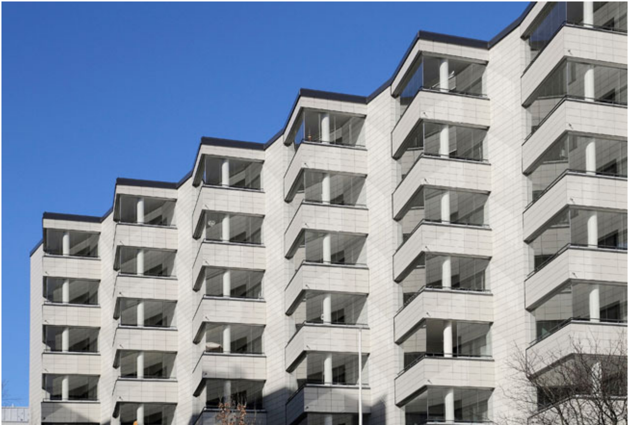
Asunto Oy Kupittaankartio julkisivuremontin jälkeen.
