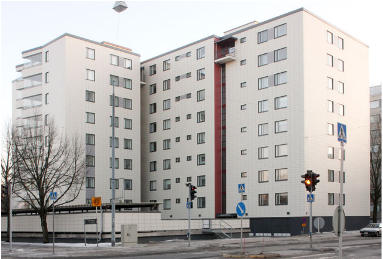
Asunto Oy Kupittaankartio julkisivuremontin jälkeen.
