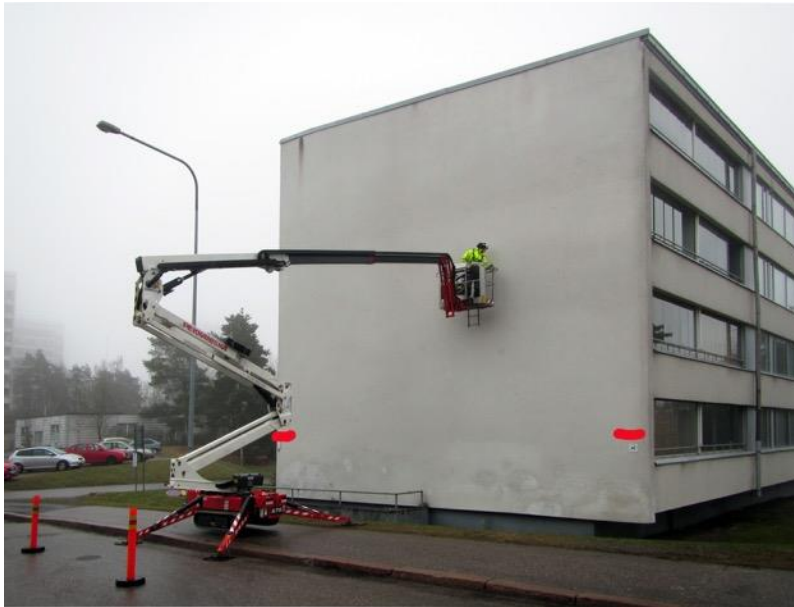
Lisälämmöneristetyin ja rapatun julkisivun kuntotutkimusta (valmistunut 1963/1990) Helsinki. Kuva: Ramboll Finland Oy
