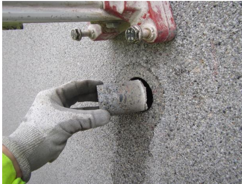
Betonilieriönäytteen otto pesubetonijulkisivusta (valmistunut 1999), Vantaa. Kuva: Ramboll Finland Oy
