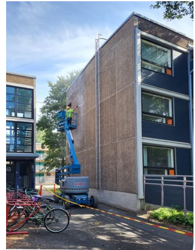
Kuntotutkimuskuva. Turku. Kuva: Julkisivukonsultointi JK Oy
