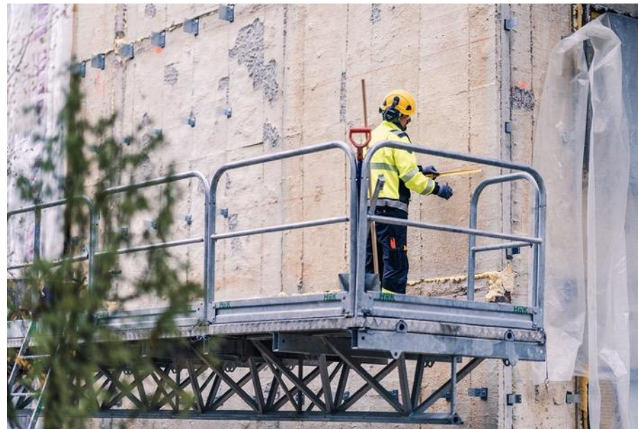
Hakinkatu, korjauskohde, Raisio. Kuva: Julkisivukonsultointi JK Oy
