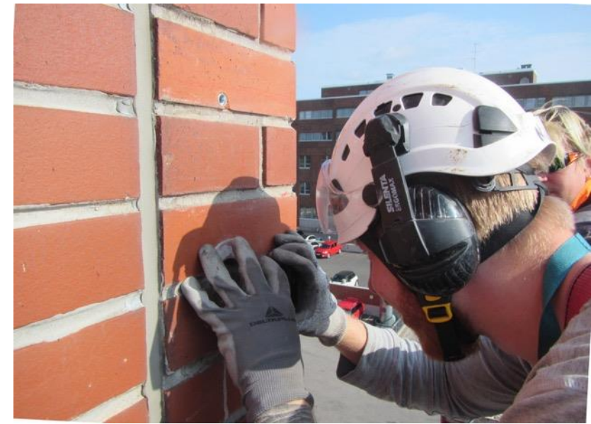
Näytteenottoreiän tarkastelua tiililaattajulkisivussa (valmistunut 1985), Helsinki. Kuva: Ramboll Finland Oy
