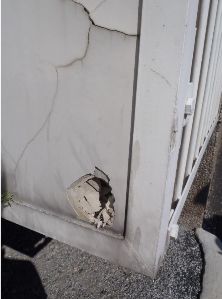
Kuva 2 : Alaprofiiliin kertynyt kosteus on säilyttänyt kevytrakenteisen kaidelevyn. ©Inari Weiho.
